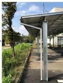
⑧雨樋設置
