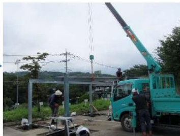
③支柱・梁組立
