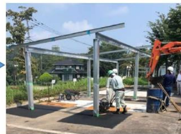
⑤アスファルト補修
