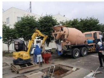
②捨てコン打設
