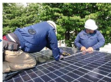
⑦太陽電池モジュール設置
