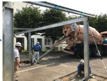
④基礎生コン打設
