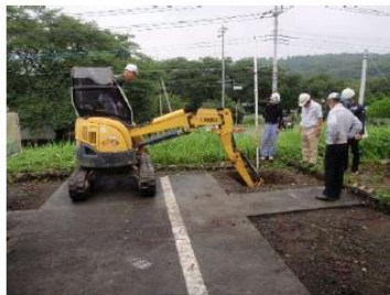
①位置出し、基礎掘削
