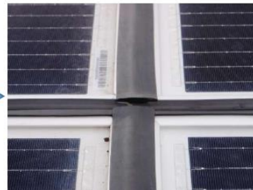
⑨止水ゴムガasket設置 （※現在、若干仕様変更あり）
